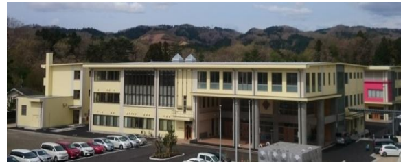
完成した新校舎
